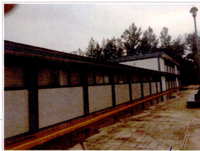
F3: Fachada posterior
