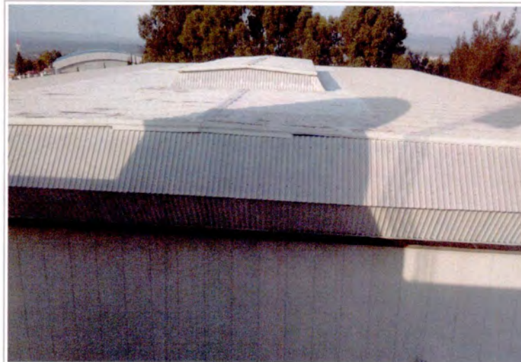
F1: Fachada principal
